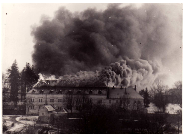
Požár zámku v Bystrém
