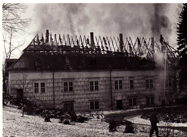
Požár zámku v Bystrém
