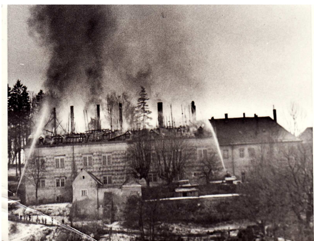
Požár zámku v Bystrém
