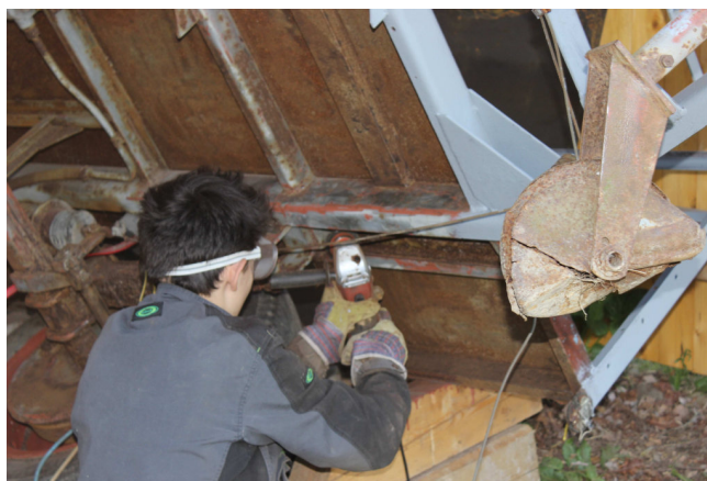
Odstraňování rzi pomocí úhlové brusky
