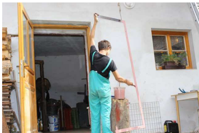
Nátěr základové barvy
