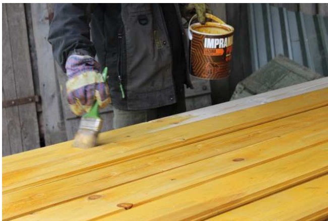
Nátěr prken pomocí štětce
