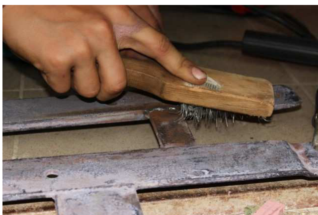
Svařování-očištění sváru pomocí drátěného kartáče
