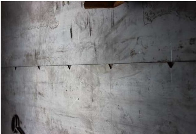
Vybroušené otvory na podlaze
