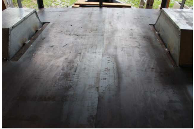
Usazení nového plechu podlahy
