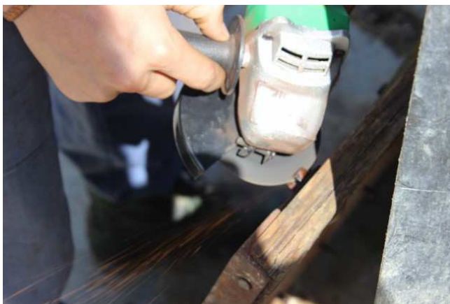
Odřezávání šroubů pomocí úhlové brusky
