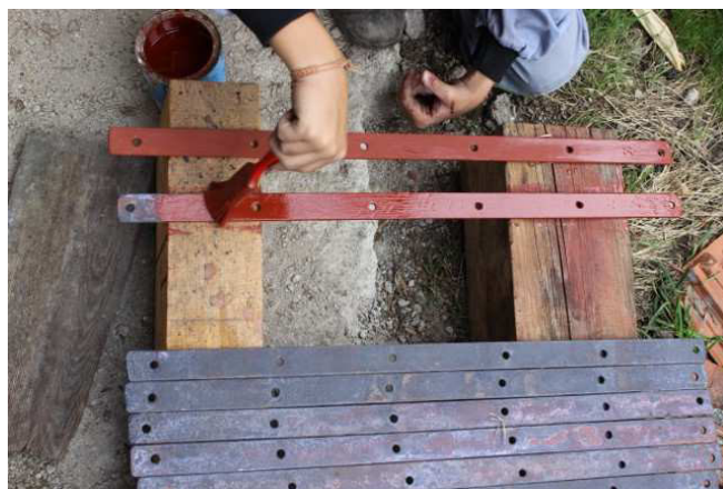
Natírání základovou barvou
