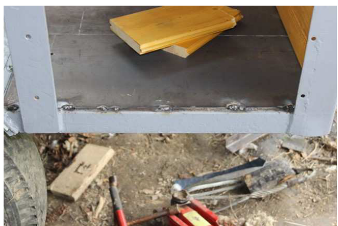
Přivaření nové podlahy na rám vleku
