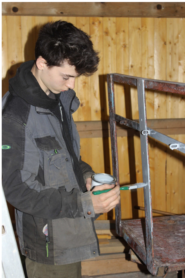
Natírání základovou barvou
