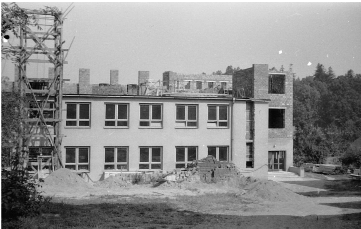
Ilustrace 38: Nástavba pavilonu
