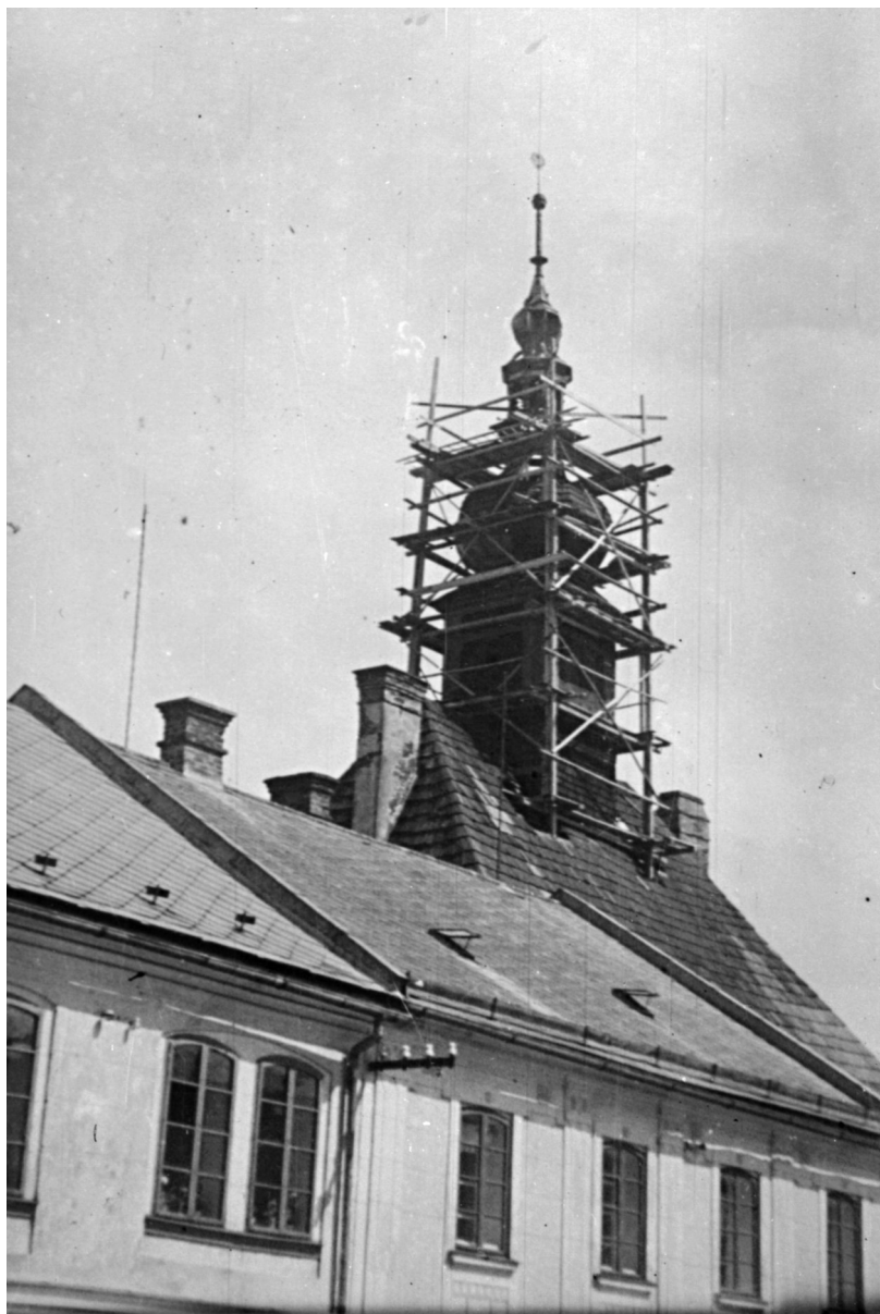
Ilustrace 21: Oprava věže radnice v Bystrém
