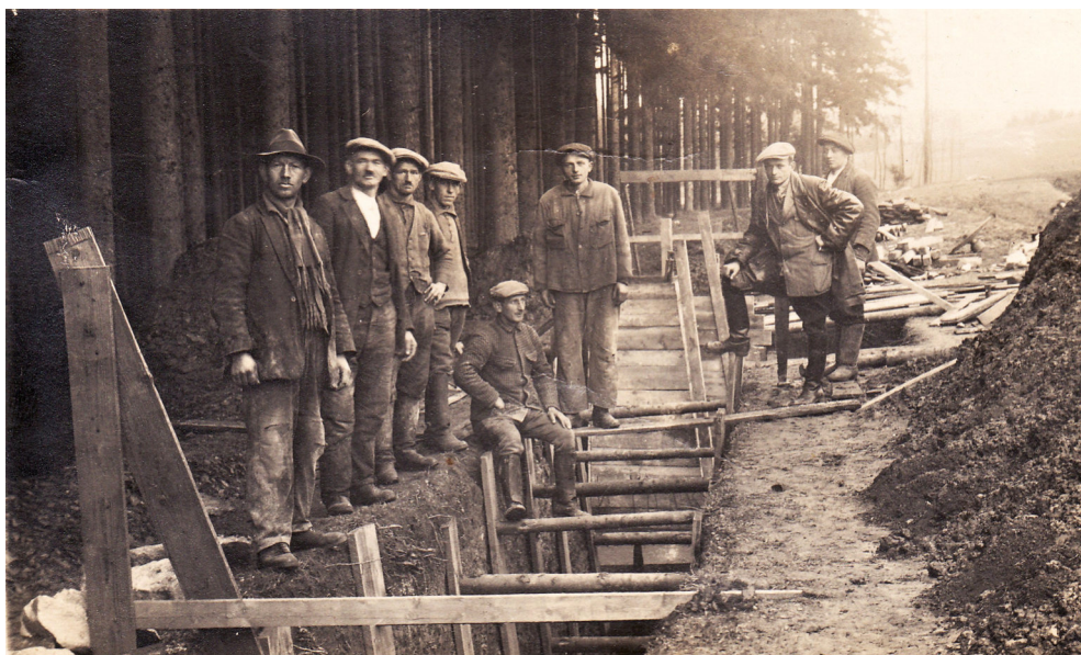
Ilustrace 17: Dělníci při stavbě vodovodu
