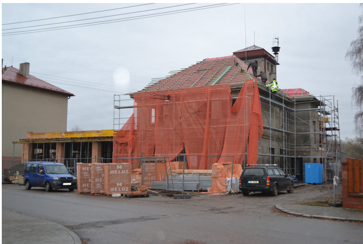
Ilustrace 24: Výstavba nové hasičské zbrojnice
