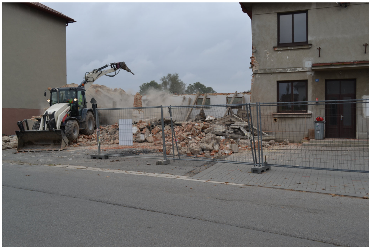
Ilustrace 23: Bourání staré hasičské zbrojnice
